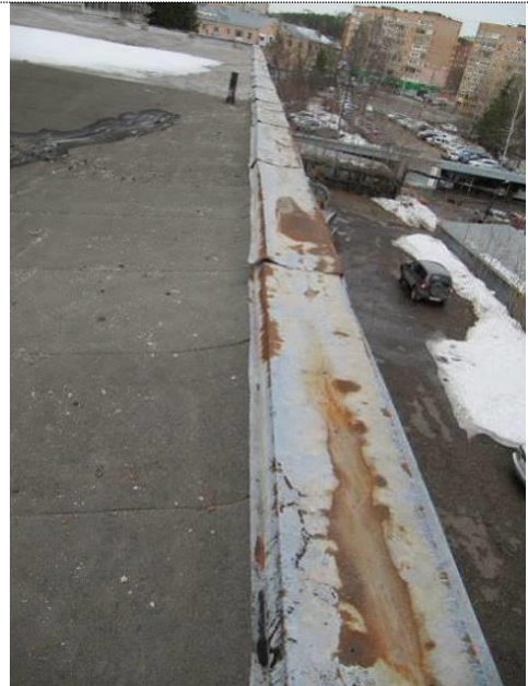
Фото 104 Состояние парапетных фартуков (характерное фото)
