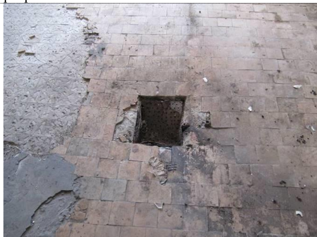
Фото 94 Состояние напольных трапов 2 этажа
