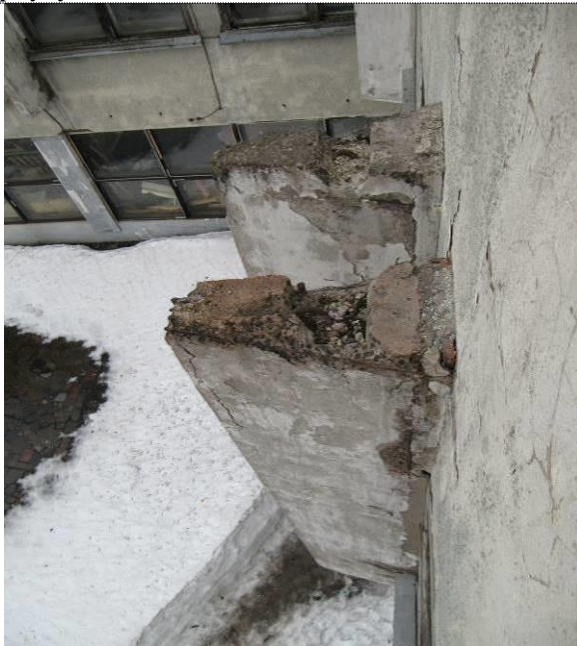
Фото 69 Характерное фото состояния импостов с разрушением материала в верхней части
