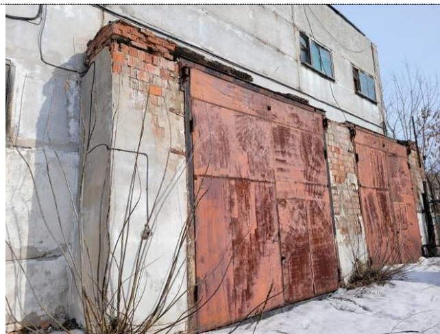
Фото 26 Разрушение выступающей части кирпичной кладки в осях 1-3/К
