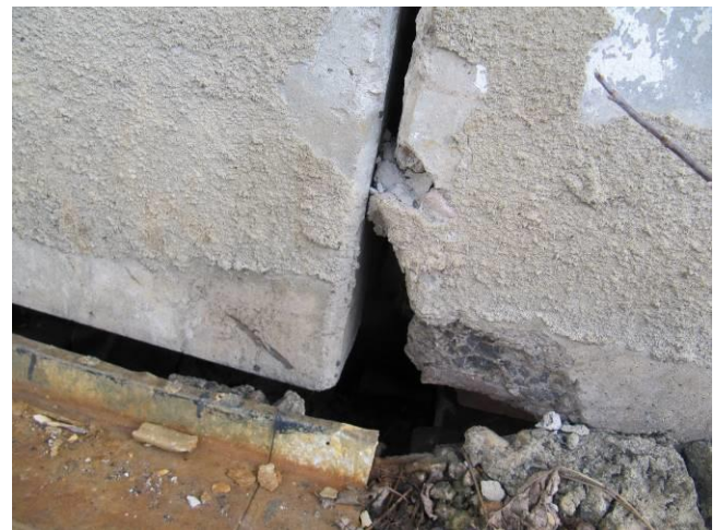
Фото 114 Сквозной зазор под цокольной стеновой панелью в осях 7/Е-Ж
