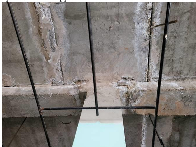
Фото 93 Некачественный узел заделки монтажного узла колонна/ригель
