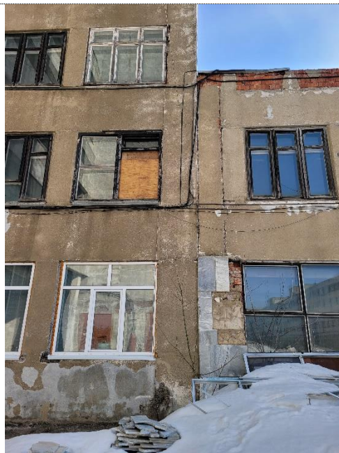
Фото 12 Участок сопряжения производственных корпусов по оси «А» (деформационный шов)
