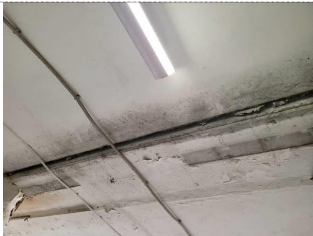
Фото 79 Перепад рустов плит перекрытия 1 этажа в районе осей 6-7/Е-Ж
