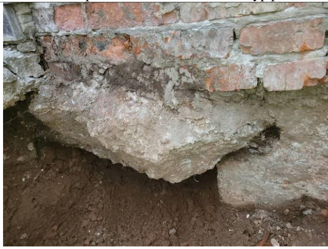
Фото 130 Бетонная подготовка под наружной стеной в районе осей 25/А1-Б1 (шурф № 6)
