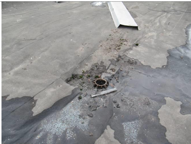
Фото 107 Вид водосточной воронки, участок застоя воды
