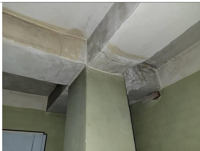
Фото 52 Замачивание, растрескивание штукатурки замоноличивания элементов каркаса технического этажа в осях 27/Б
