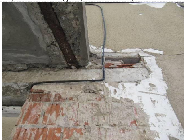
Фото 30 Отслоение штукатурки, частичное разрушение кирпича в районе козырька над входной группой в столовую в осях 7/Б
