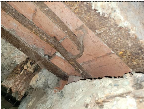
Фото 133 Металлическая фундаментная балка под наружной стеной в районе осей 7/Г-Д (вид снизу) (шурф № 7)
