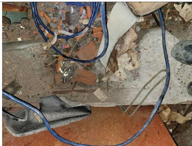
Фото 44 Оголение арматуры монолитного участка и разрушение опорного ребра связевой плиты перекрытия 4 этажа
