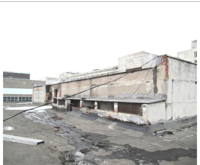
Фото 100 Следы замачивания покрытия технического этажа, узел заделки стыка колонны и ригеля в осях 4/Ж
