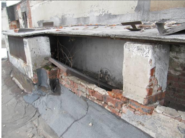
Фото 105 Разрушение кирпичной кладки над вентиляционной шахтой, отсутствует жалюзийная решётка
