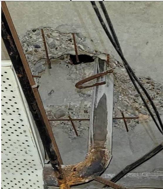
Фото 59 Отверстие в плите перекрытия 1 этажа
