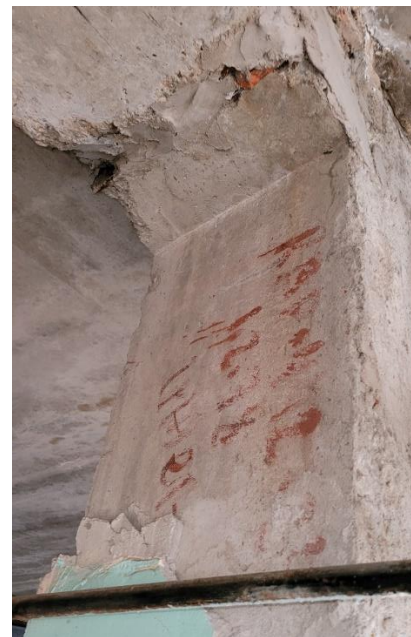
Рис. 25 Сохранившаяся маркировка на поверхности колонны в осях 6/В в уровне второго этажа КВР 442-24
