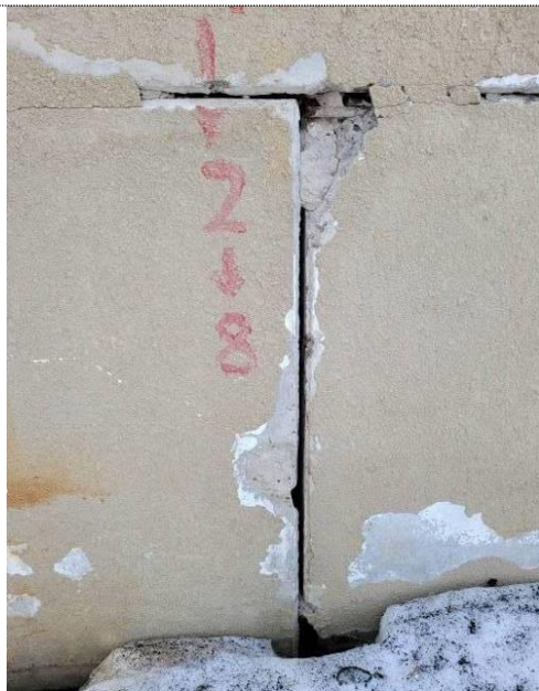
Фото 27 Нарушение герметизации, разрушение швов стеновых панелей столовой
