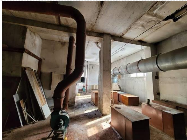
Фото 89 Состояние плит перекрытия 2 этажа со следами протечек, выкрошиванием швов
