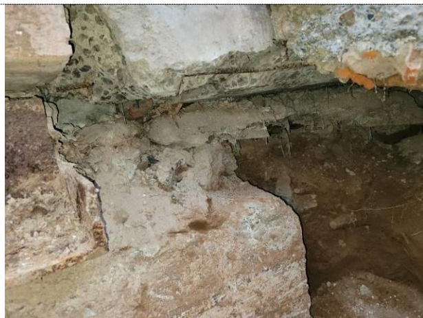
Фото 134 Отсутствие фундаментной балки под наружной стеной (панелью) в районе осей 7/Д-Е, сколы бетона цокольной стеновой панели (шурф №7)
