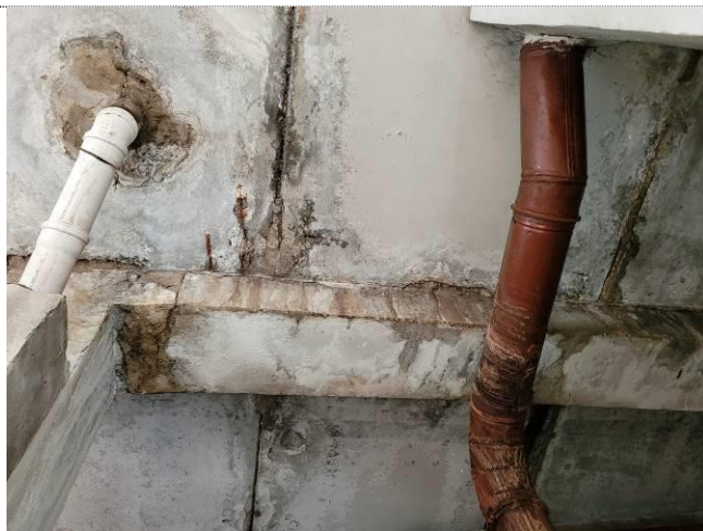
Фото 91 Проступают арматурные сетки плит, повреждённые коррозией в осях 2/И
