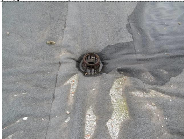
Фото 71 Вид водосточной воронки, состояние гидроизоляционного покрытия
