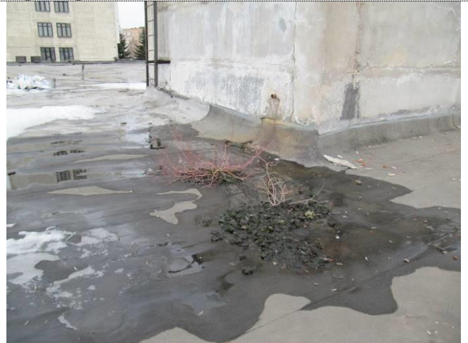
Фото 106 Нарушение кровли из-за растительности на её поверхности
