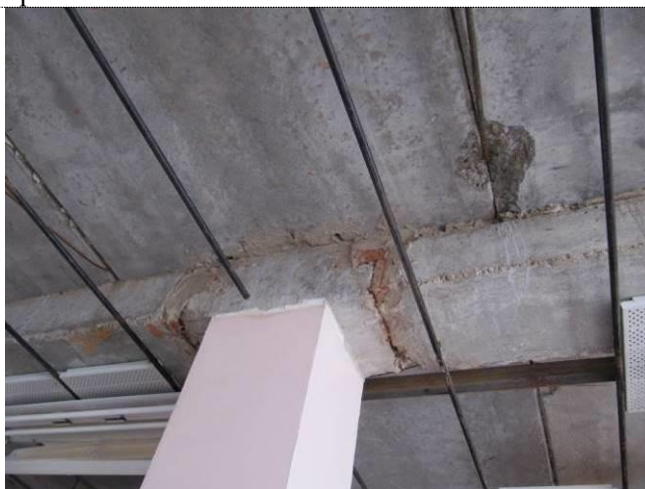
Фото 65 Сколы в плитах в местах подвесок, частичное заполнение кирпичом шва колонна/ригель
