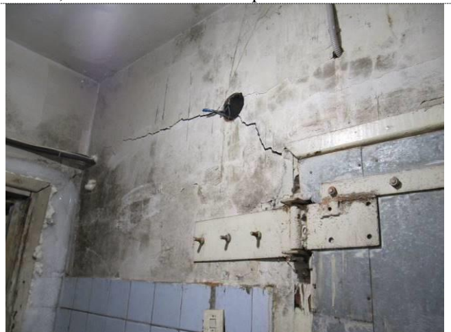
Фото 82 Трещина в перегородке холодильной камеры 1 этажа в районе осей 5-6/Ж-И
