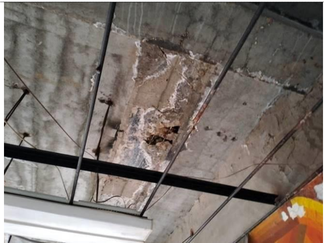
Фото 96 Состояние монолитного участка в перекрытии 2 этажа в осях 1-2/И-К
