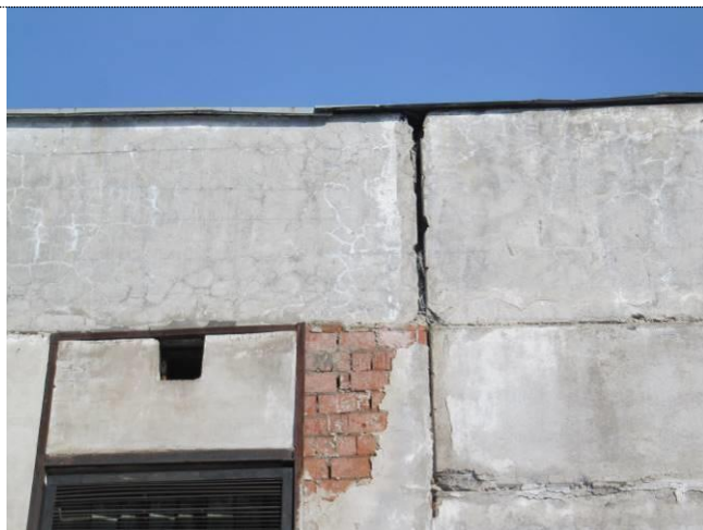
Фото 29 Отслоение штукатурки простенка, выкрошивание швов стеновых панелей (характерное фото для фасадов столовой)
