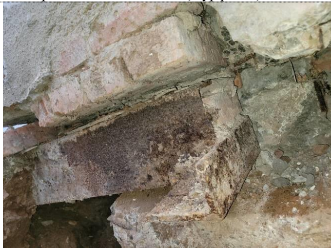
Фото 132 Металлическая балка под наружной стеной в районе осей 7/Г-Д (шурф № 7)
