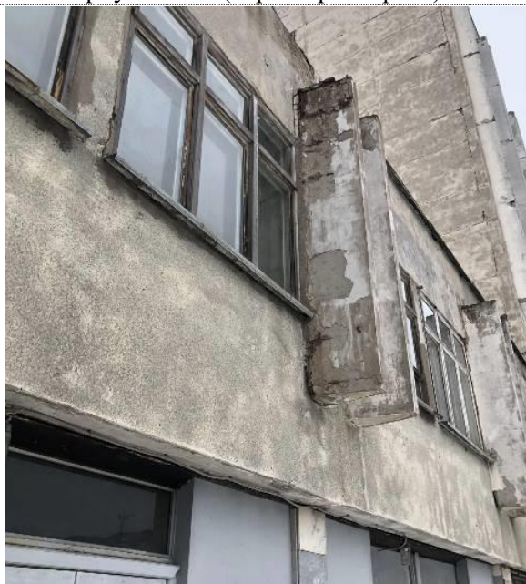
Фото 23 Участок разрушения верхней части импоста в осях 28/В 1
