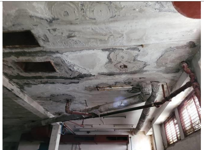
Фото 80 Участок перекрытия 1 этажа в осях 1-3/Ж-К, места интенсивных протечек
