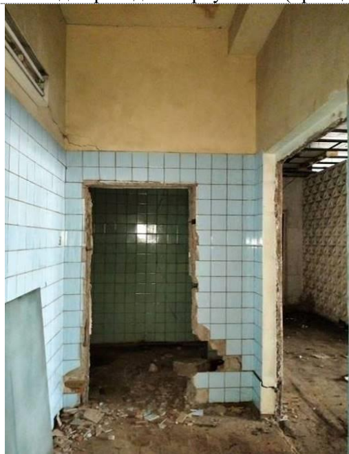
Фото 34 Аварийная перегородка 1 этажа в районе осей 26-27/Л-М
