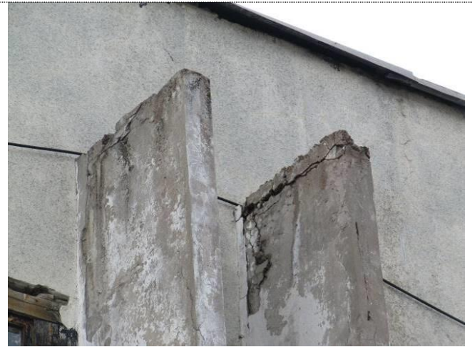
Фото 112 Растрескивание бетона импоста
