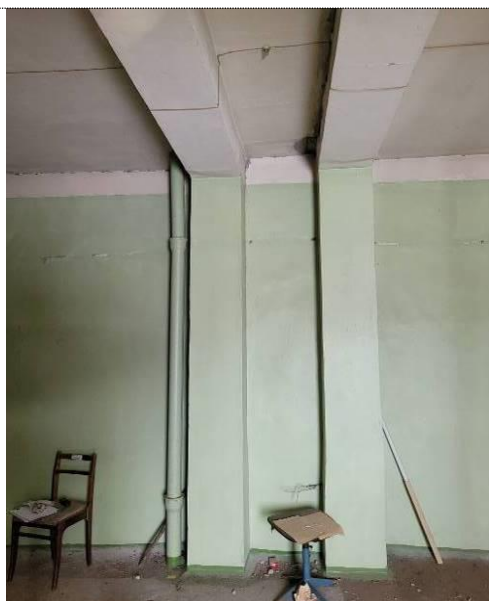
Фото 53 Деформационный шов в уровне технического этажа по оси «Ж»
