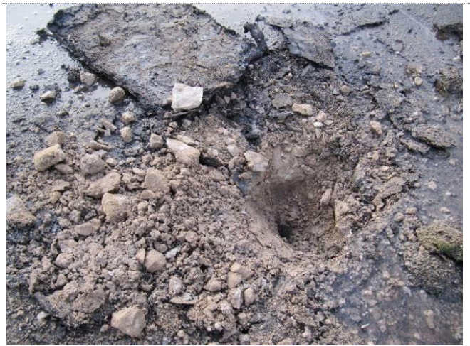
Фото 108 Вскрытие кровли № 1. Утеплитель во влажном состоянии
