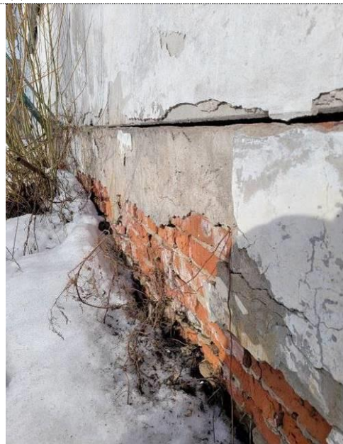
Фото 28 Состояние цокольной части кирпичной кладки столовой (фасад в осях «7-1»)
