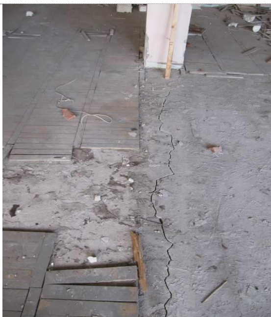
Фото 63 Растрескивание стяжки под верхним покрытием полов
