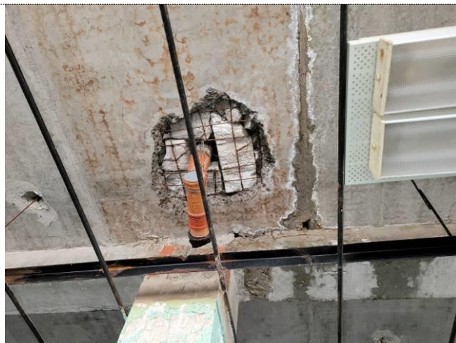
Фото 92 Пробивка по месту отверстия в плите перекрытия 2 этажа в осях 2/В
