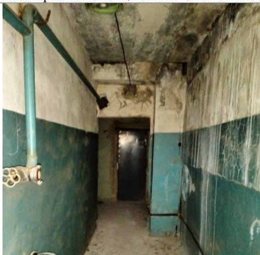
Фото 99 Следы протечек кровли технического этажа
