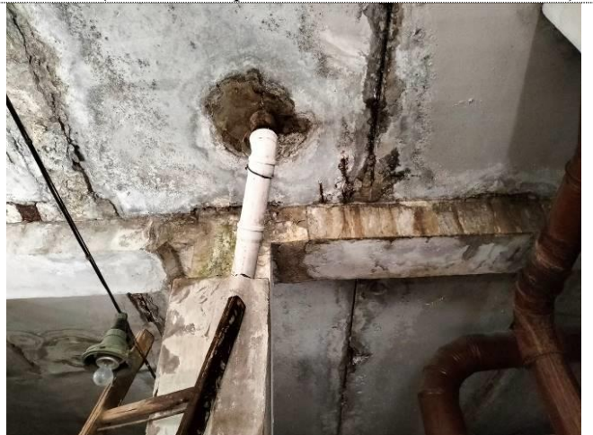
Фото 90 Следы протечек в швах плит перекрытия 2 этажа, труба ливневой канализации в осях 2/И (помещение вент. камеры)
