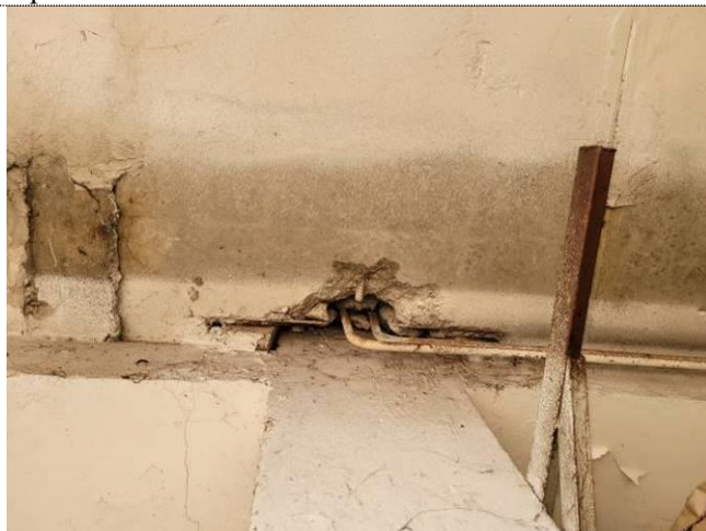
Фото 81 Нарушение плиты перекрытия 1 этажа в месте пробивки отверстия под трубопроводы
