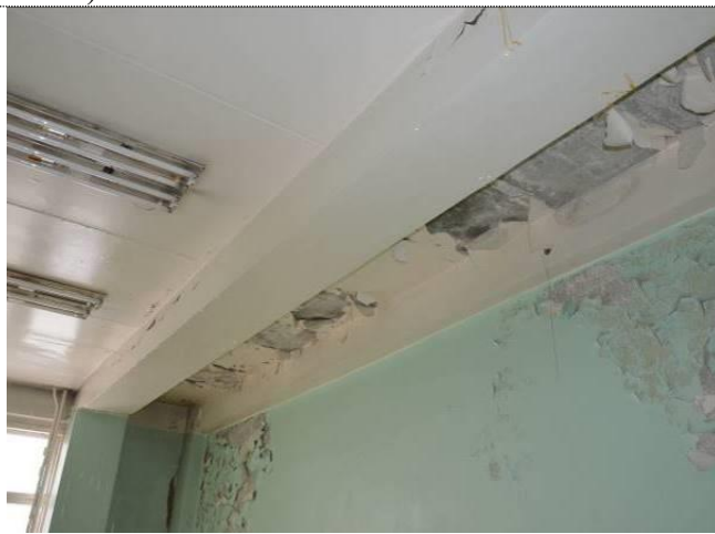
Фото 41 Вид перекрытия в районе деформационного шва по оси «Ж»
