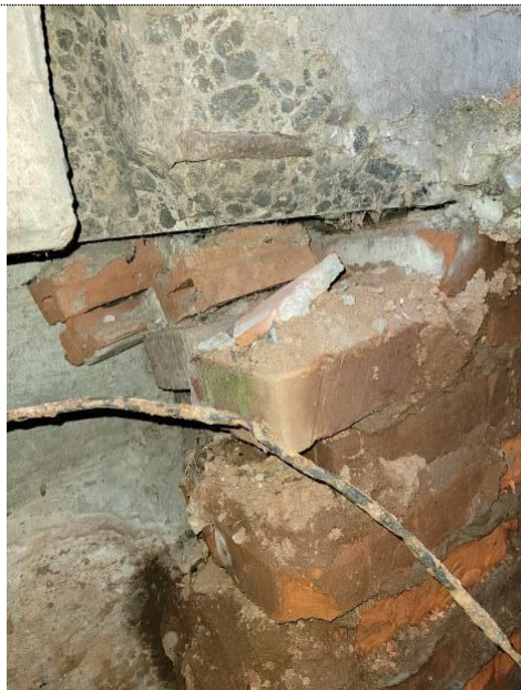
Фото 137 Разрушение кирпичной кладки фундамента наружной стены, сколы бетона цокольной стеновой панели (шурф № 8)
