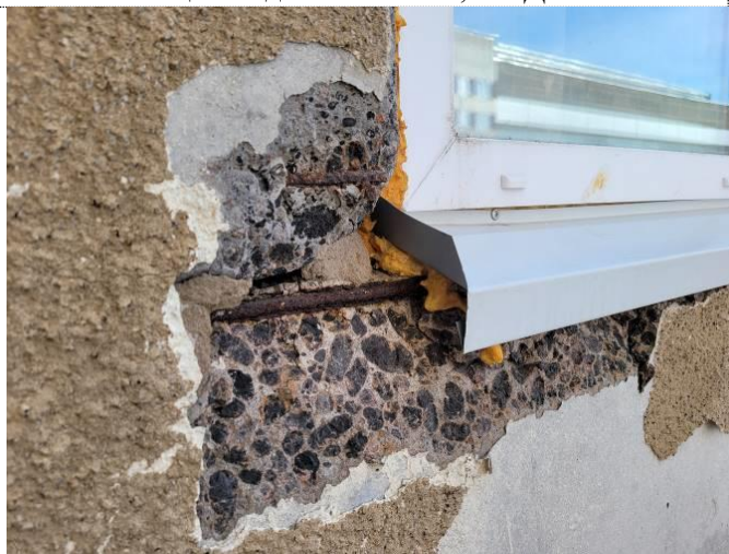
Фото 21 Оголение арматуры цокольной стеновой панели корпуса 200В (характерное фото)
