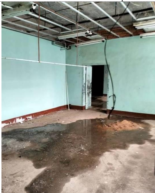
Фото 33 Следы сквозных протечек с кровли на полах 1 этажа
