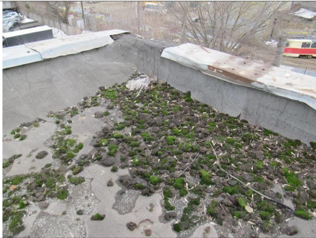
Фото 109 Растительность на поверхности кровли в осях 1/К, отсутствует фартук
