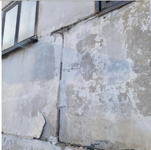
Фото 118 Растрескивание стеновой панели в месте просадки кирпичной кладки в основании (шурф № 1)
