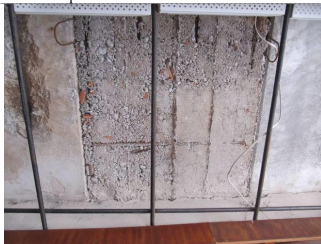
Фото 66 Низкое качество бетонирования монолитного участка в покрытии 2 этажа
