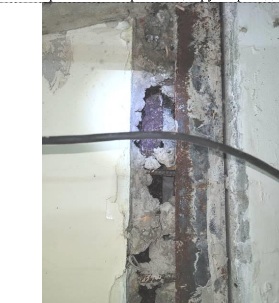
Фото 83 Оголение арматуры монолитного участка на отм. +3,000 в районе деформационного шва в осях 4-5/А
