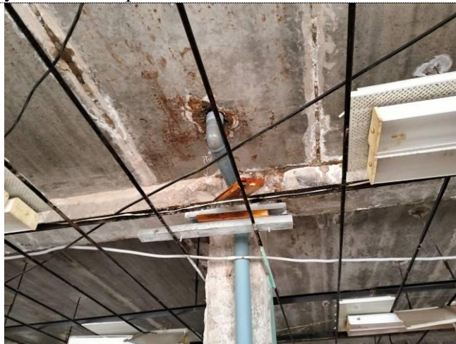
Фото 95 Состояние плит перекрытия 2 этажа в районе водосточной воронки в осях 6/В
