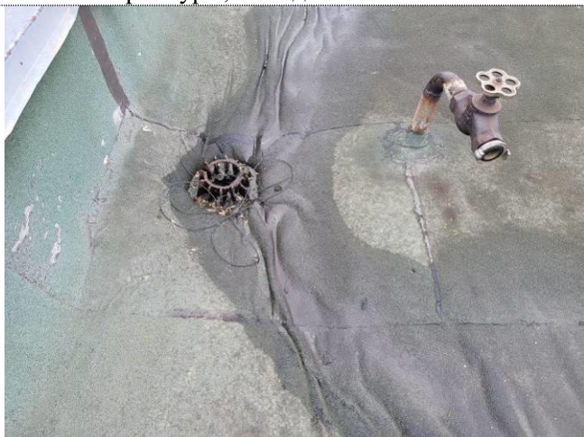
Фото 17 Водосточная воронка на кровле технического этажа
