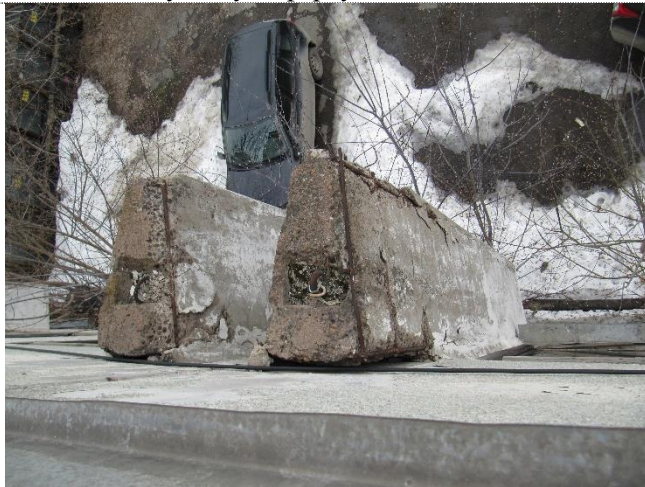
Фото 111 Состояние импостов: эрозия, оголение арматурных стержней, коррозия
