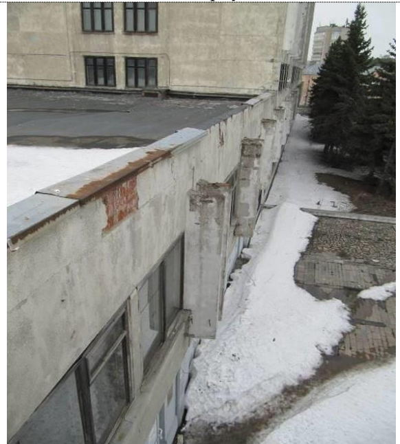
Фото 70 Состояние парапетной части наружных стен
