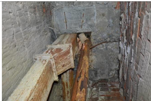
Фото 40 Состояние монолитного перекрытия канала в районе осей 28/Б (фото в уровне 2 этажа)
