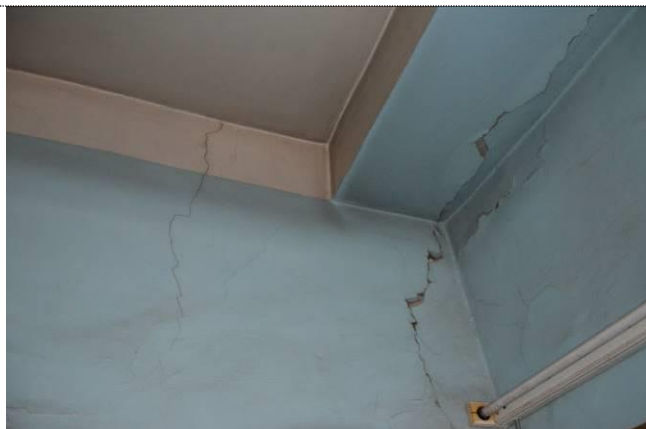
Фото 39 Растрескивание перегородки в районе деформационного шва по оси «А» (фото в уровне 2 этажа)
