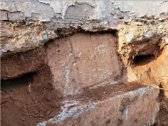
Фото 117 Монолитная лента в основании кирпичной кладки цоколя (шурф № 1)
