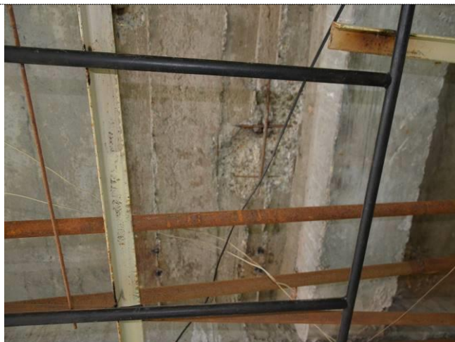
Фото 43 Оголение арматуры монолитного участка (в перекрытии 3 этажа)
