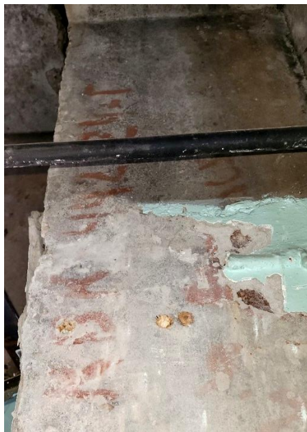
Рис. 24 Сохранившаяся маркировка на поверхности колонны в осях 1/А в уровне второго этажа КВК 442-24
