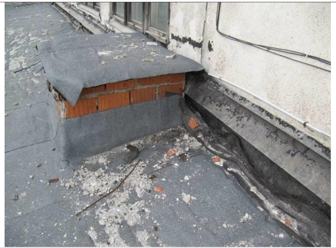
Фото 68 Нарушение примыкания кровли к выше-расположенным стенам корпуса 200В
