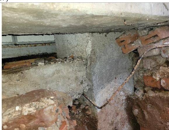
Фото 136 Шурф № 8, открытый зазор между панелью наружной стены и полом
