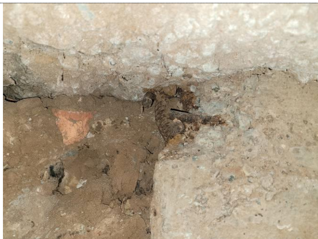
Фото 121 Участок оголения арматуры подколонника в шурфе № 2
