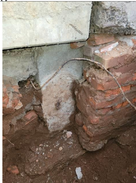
Фото 138 Отсутствие фундаментной балки под наружной стеной в районе осей 7/Ж-Е, нет опирания цокольной панели (шурф № 8)
