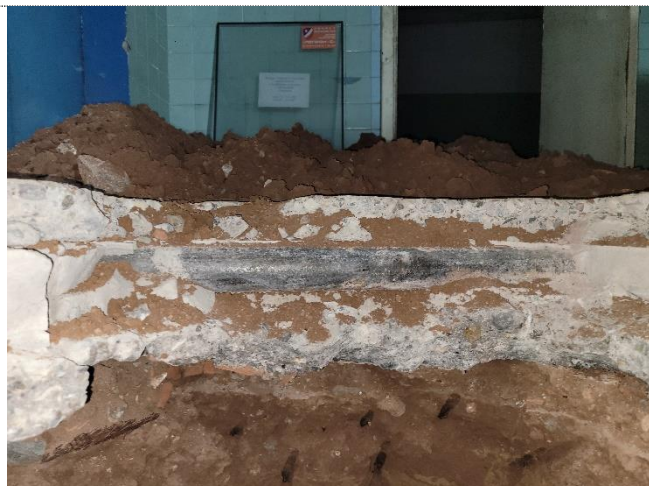
Фото 122 Состав пола выявленный в шурфе №2
