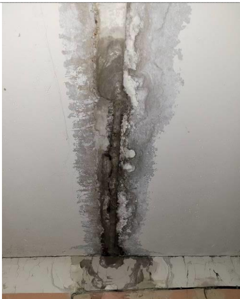
Фото 101 Характерный участок протечек швов плит покрытия технического этажа
