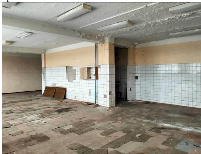
Фото 46 Состояние полов и внутренних отделочных покрытий. Промораживание протечек в перекрытии (фото 7 этажа)
