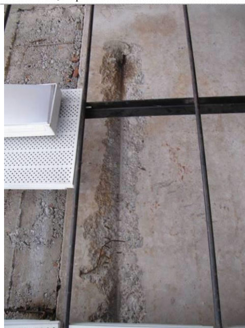
Фото 64 Нарушение (отрыв) рабочего стержня плиты покрытия
