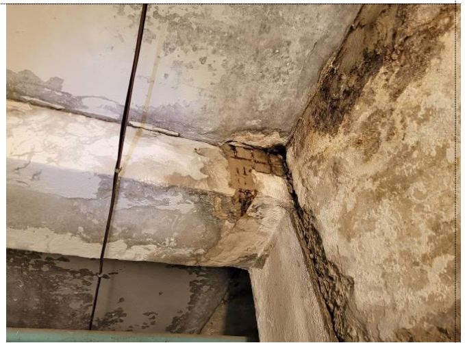
Фото 100 Следы замачивания покрытия технического этажа, узел заделки стыка колонны и ригеля в осях 4/Ж
