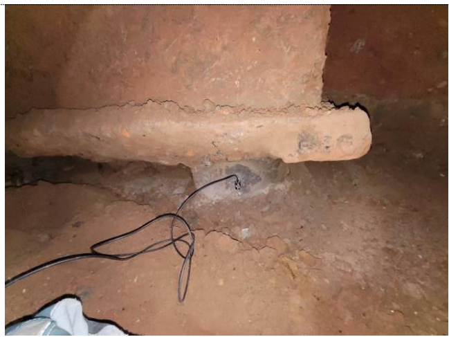
Фото 124 Определение длины свай в шурфе № 3
