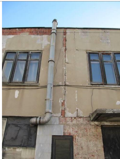
Фото 24 Деформационный шов между столовой и проходной (со стороны дворового фасада)
