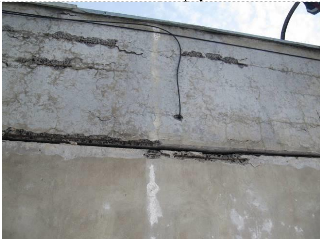
Фото 15 Нарушение парапетных стеновых панелей, оголение арматуры, выпадение шва
