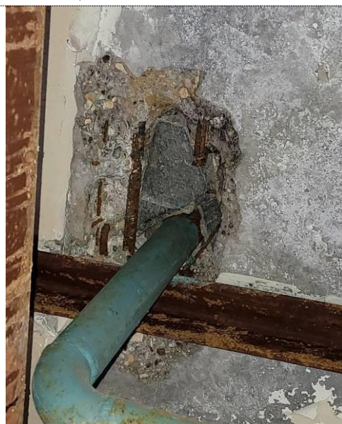
Фото 54 Пробивка отверстия в плите перекрытия тех. этажа с нарушением арматуры
