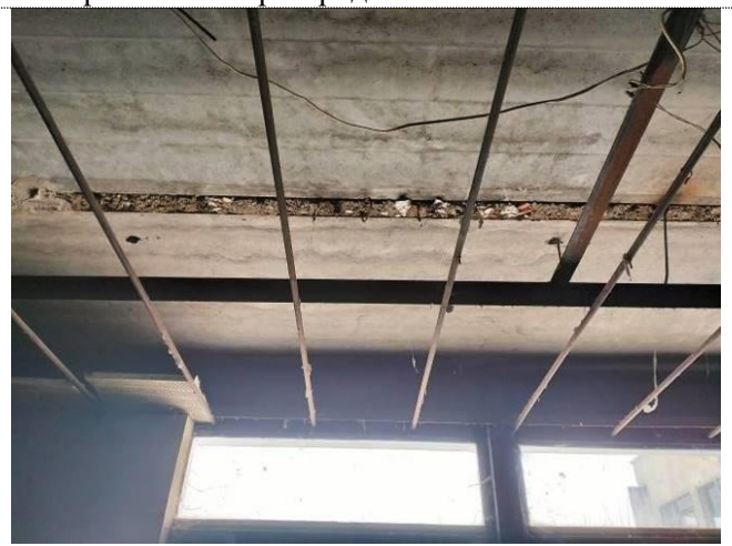
Фото 58 Увеличен шов плит перекрытия 1 этажа
